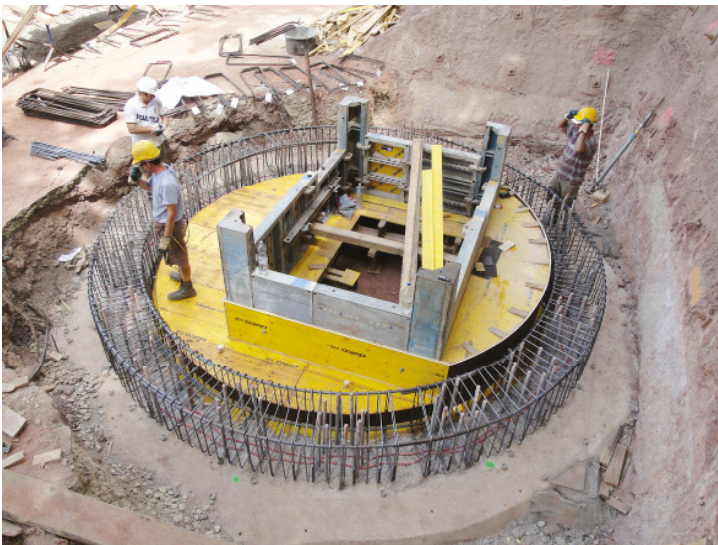
Bild li. Pegelschacht im Bauzustand, Bild re. Schwimmer-Seil-Gegengewicht-System
